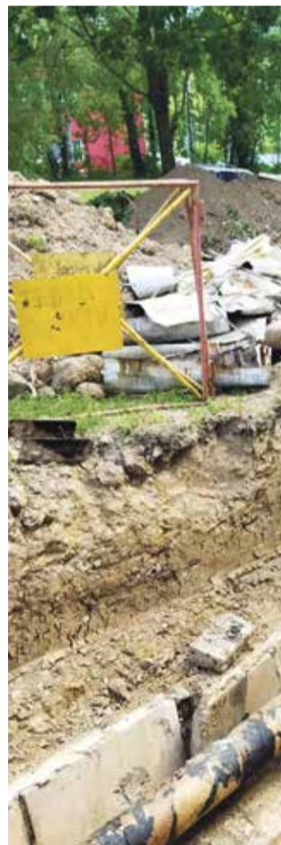
■ Ремонт труб на Курчатова, 27
