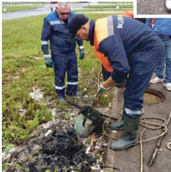
■ Работы по прочистке хозфекального коллектора
