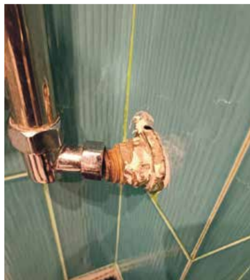
■ Ремонтные работы в квартирах
