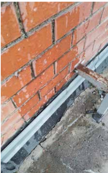
■ Ремонт кровли в зимний период
