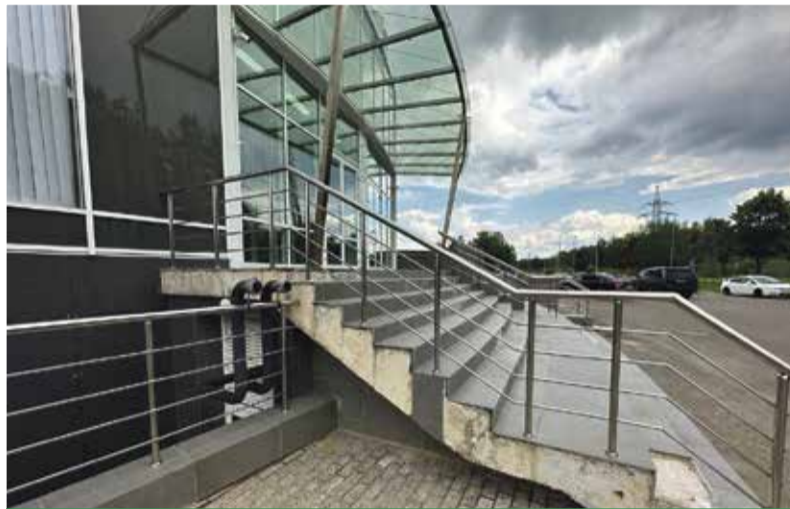
Приехал в Технопарк, а тебя встречает отвалившаяся плитка. Здание выглядит так, как будто ему лет 20 и оно активно эксплуатировалось, но никак не три года!
