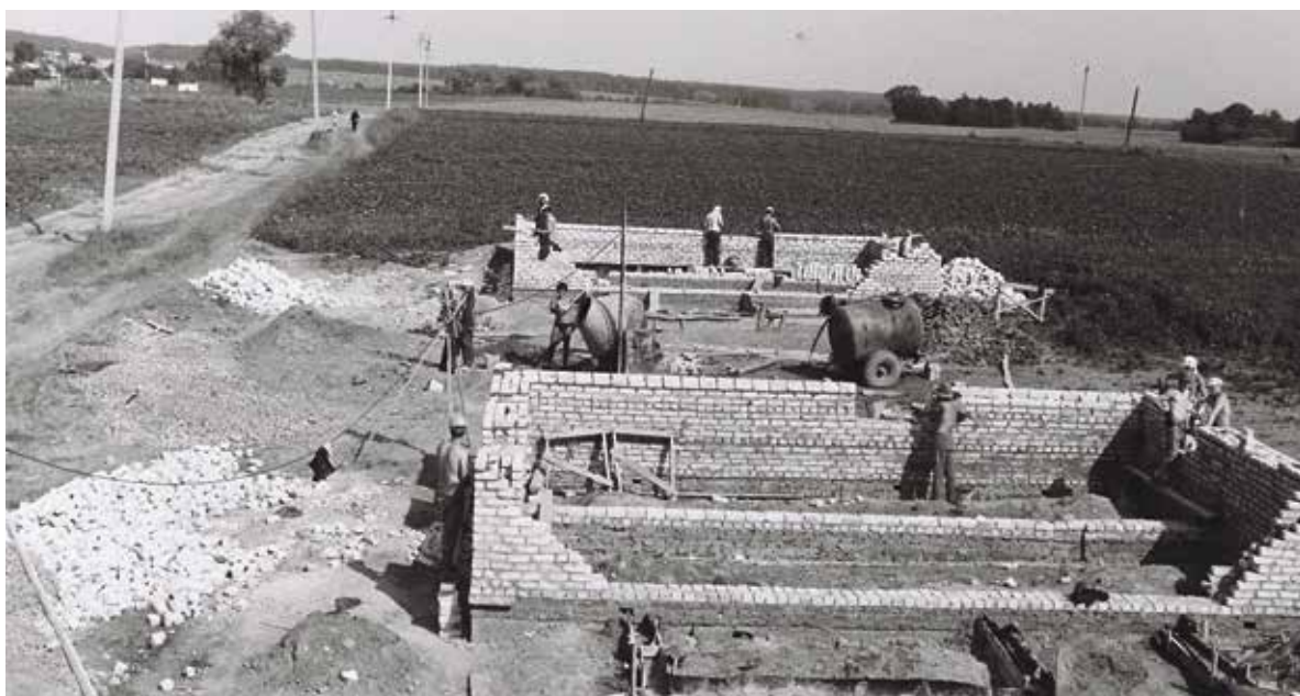
■ Мосальский район, строительство жилых домов, отряд «Память — 8» КФ МГТУ имени Баумана.
