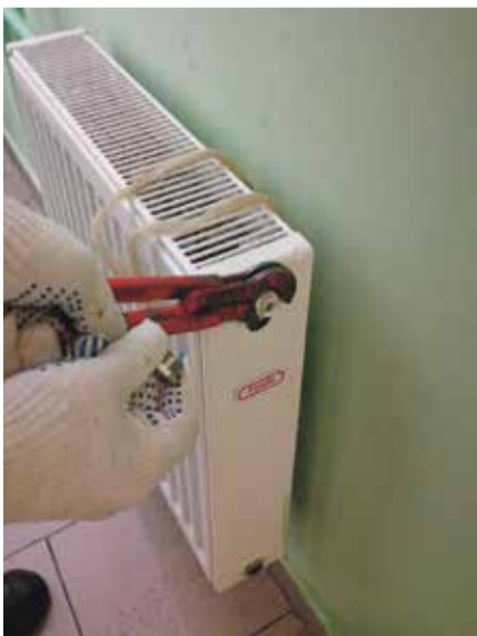
■ Ведется работа в домах на проспекте Маркса
