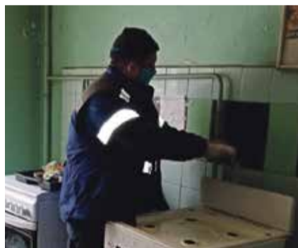
■ Специалист осматривает газовое оборудование в одном из обнинских жилых домов
