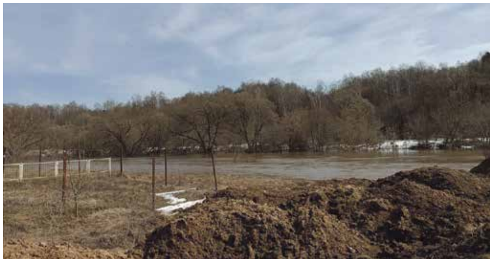
► Стройку на Текстильной в Ермолино защищают земляными валами
