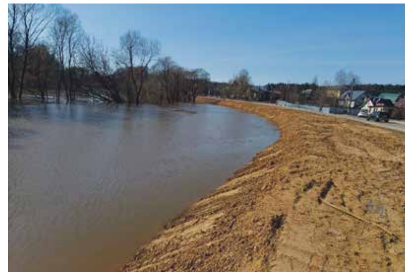
► Будущая набережная в Боровске пока успешно противостоит наводнению
