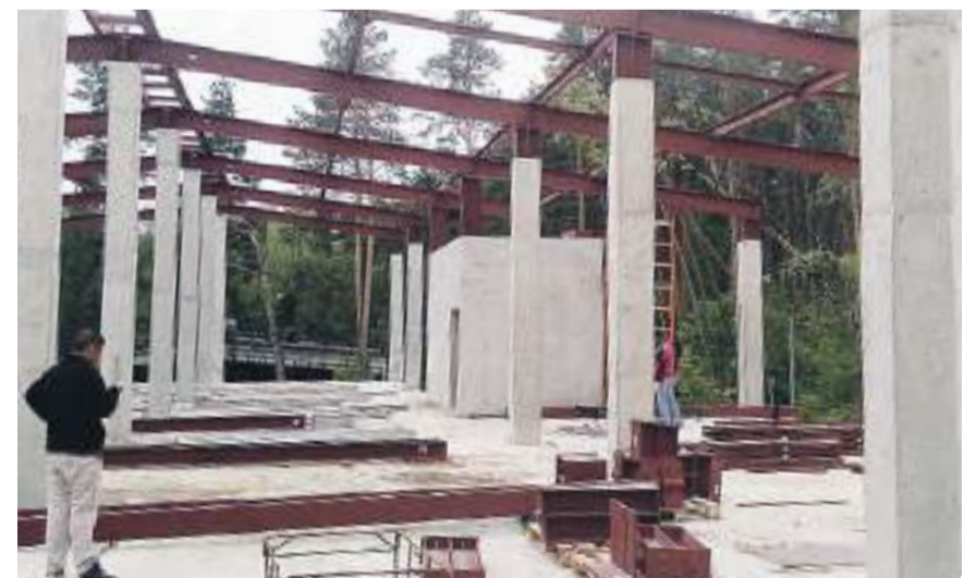
■ Строительство объекта «Центр доклинических исследований».
