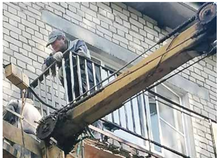
■ Работник МП УЖКХ ремонтируют обнинский балкон
