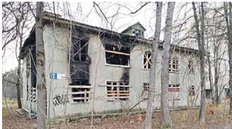
■ За капремонт этого сгоревшего дома на улице Парковой бывшим жильцам больше не нужно платить
