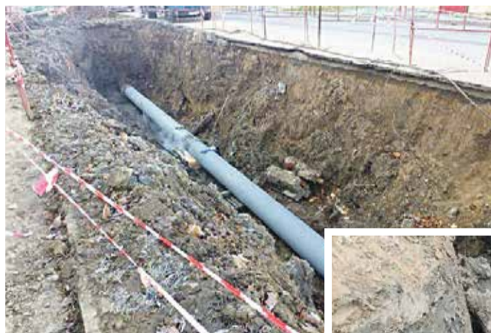
■ Замена водопроводных труб.
