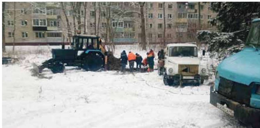
■ В этом году работники «Водоканала» устранили 71 аварию
