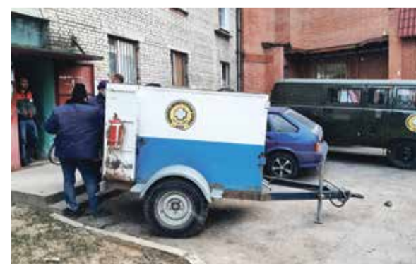
■ Сварочный пост прибыл на место аварии
