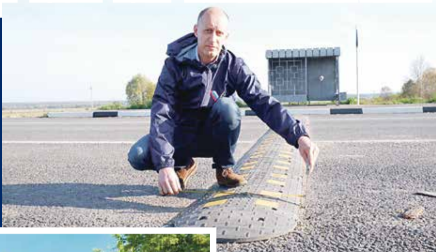
■ Дмитрий Афанасьев во время проверки качества выполнения работ по укладке искусственной неровности в одном из населенных пунктов региона
