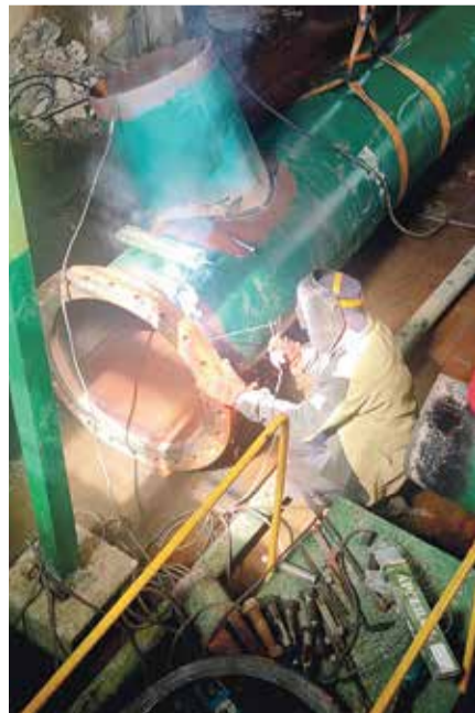
■ Работник МП Водоканал проводит ремонтные работы
