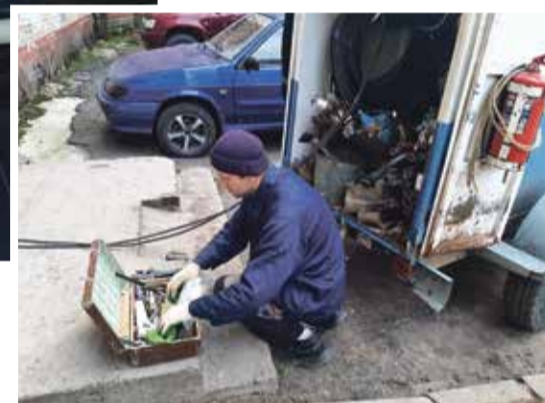
■ Сварочный пост аварийной службы МП УЖКХ задействован ежедневно
