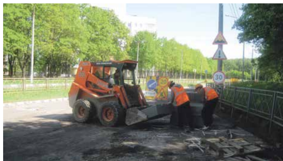
Ремонт одной из обнинских дорог
