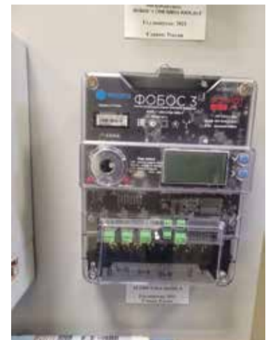
■ Современный прибор учета электроэнергии Фобос
