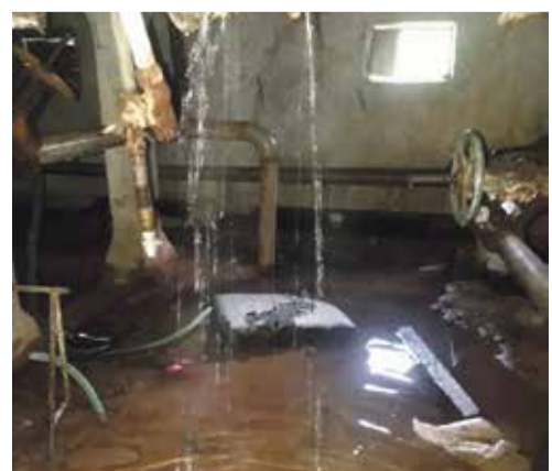
■ Подвал в доме № 2 поселка Малоярославец-5
