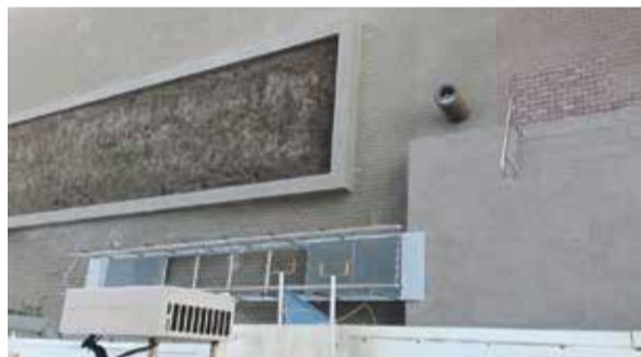
■ В городской администрации уже начали устанавливать пандус
