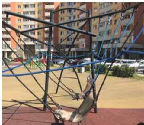
■ Ремонт конструкций на детской площадке по Маркса, 87
