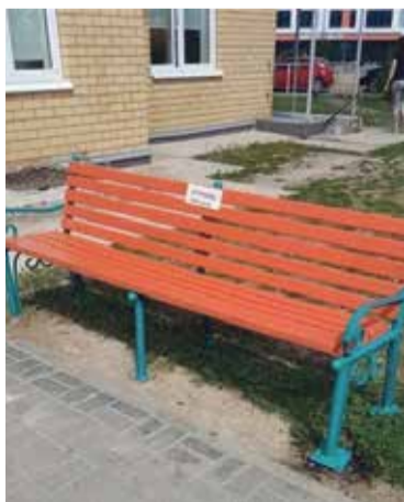
■ Ремонт и покраска скамейки на Маркса, 81
