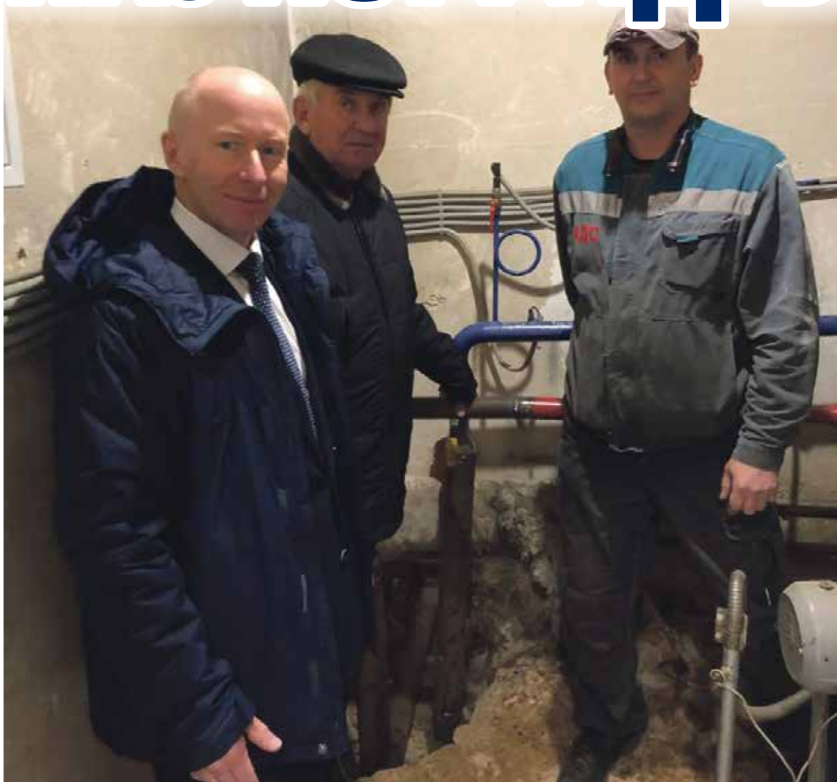
■ Сергей Волотовский с подчиненными — лично контролирует, как ведутся ремонтные работы.
