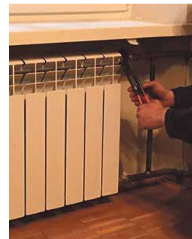
■ Ремонт системы отопления дело сложное и лучше его выполнять специалистам
