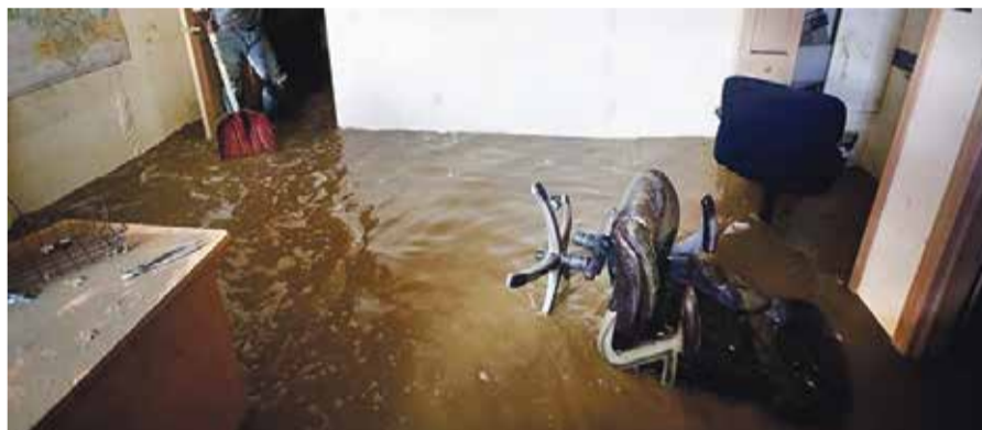
■ Потоп в одной из обнинских квартир
