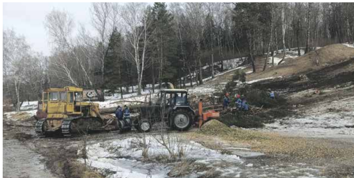
■ Вырубка деревьев для строительства новой ЛЭП уже началась
