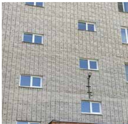
Заменяли деревянные окна на Маркса, 63
