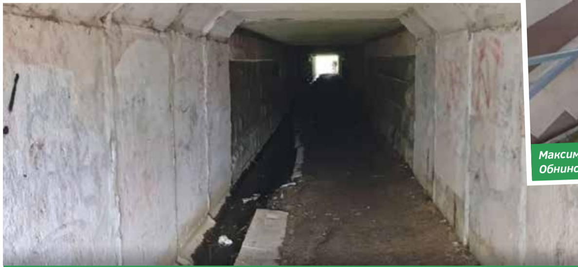
Технический тоннель недалеко от станции. Раньше через него гоняли скот. Теперь там ходят люди.
